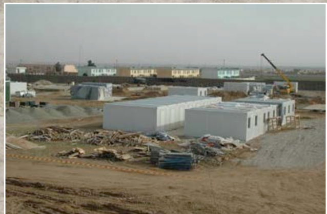
CNL under byggnation. Bilden är hämtad ur FS10 Minnesbok.
