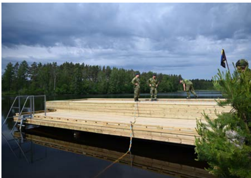
En ny dykbrygga har ersatt den gamla. Ett arbete som TakA-eleverna genomfört med stöd från andra enheter ur Ing 2. Fler bilder finns i slutet av tidningen.
